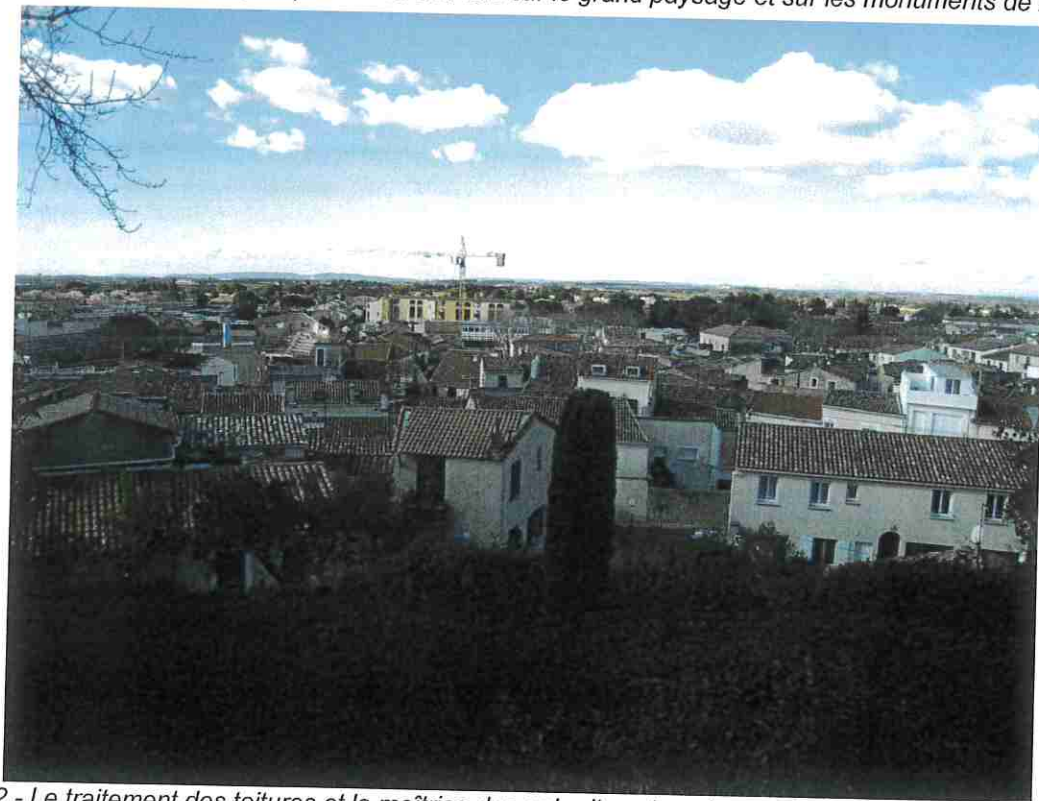
Photo 2 - Le traitement des toitures et la maîtrise des gabarits ont un impact important dans la qualité des vues
